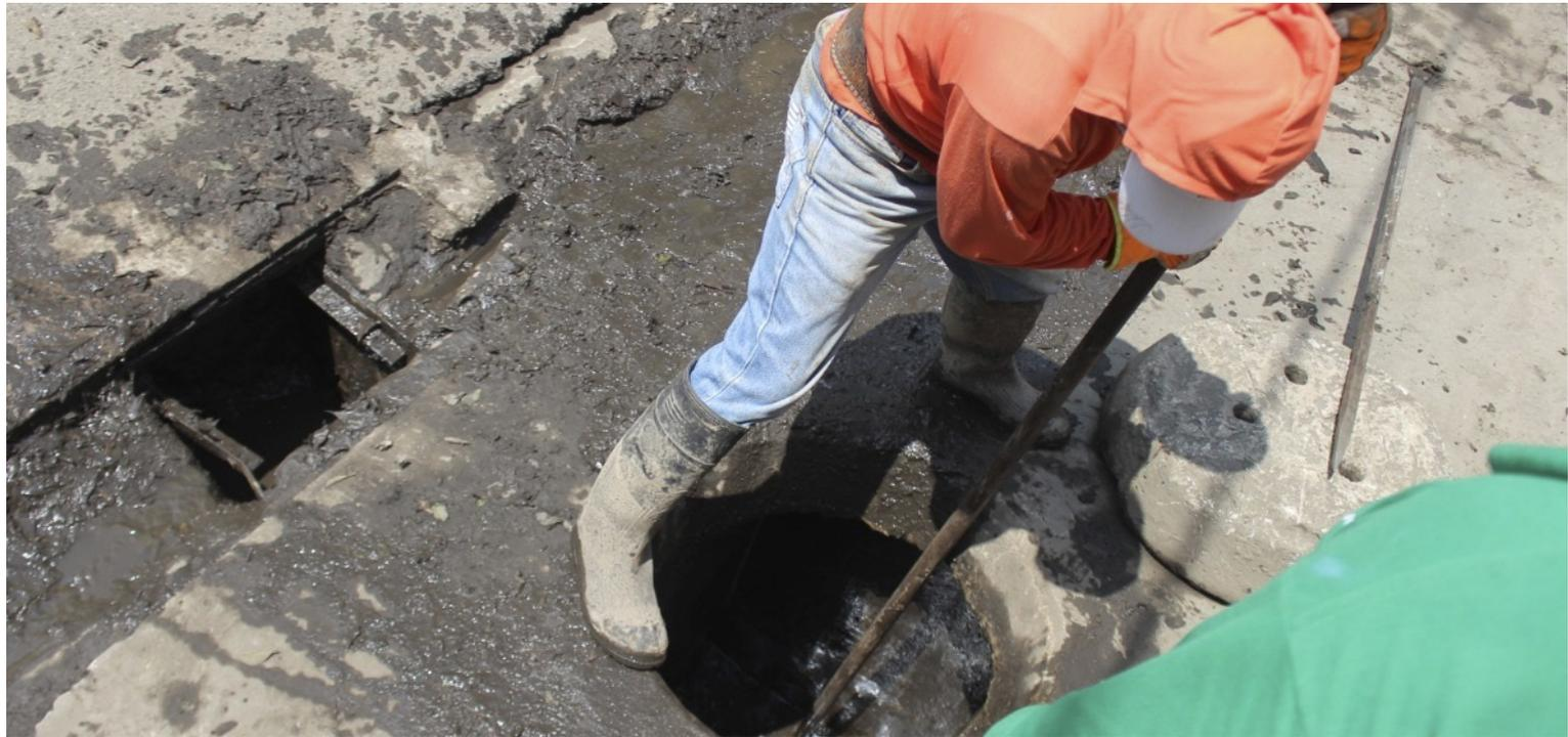
**E**l Sistema de Agua Potable y Alcantarillado del municipio de Cuernavaca (SAPAC), a través del área de alcantarillado dio inicio con el programa calendarizado de mantenimiento preventivo en la red de drenaje en diferentes puntos de la ciudad, a fin de mantener las líneas en perfectas condiciones y evitar taponamientos e inundaciones durante el temporal de lluvias.
